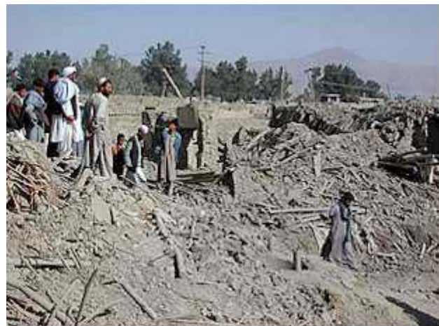
Un grupo de afganos contempla los destrozos producidos por la bomba de EE UU lanzada por error sobre su barrio
